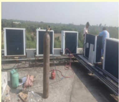
चित्र परिचय: एचवीएसी के बाहरी इकाई के कंप्रेसर का पुनर्स्थापन।
